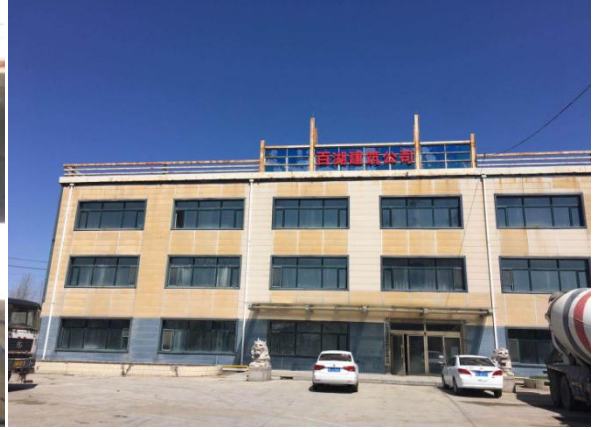
办公楼和生产厂房
