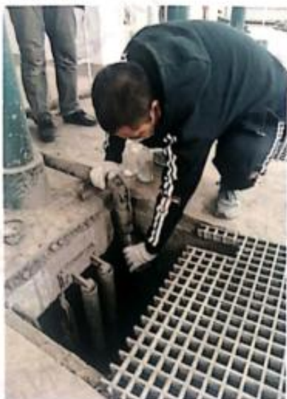
附件 现场采样照片
