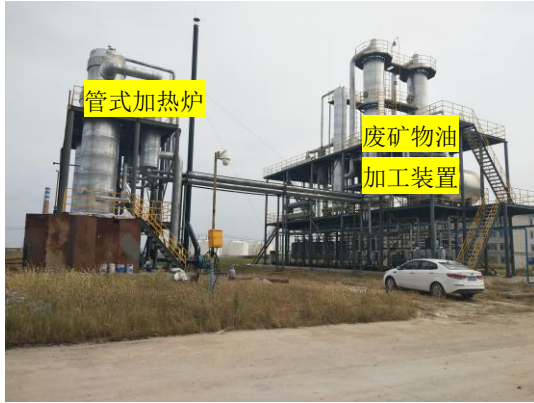
管式加热炉及废矿物油加工装置
