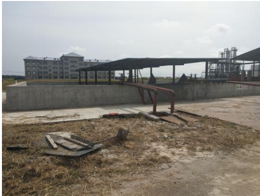
污泥储池现状
